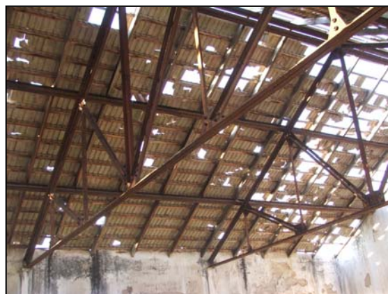
גג בית אריזה – קונסטרוקציה פלדה וקירוי רעפים ללא תקרה אופייני לבתי האריזה באזור.
