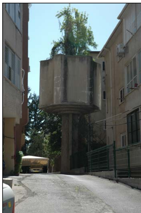
מגדל מים על עמוד בטון בודד רחוב פינסקר
