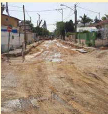
בורוכוב החלפת קו ביוב, ניקוז ומים + עבודות פיתוח
